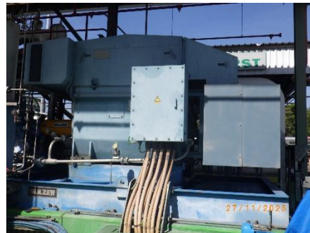
เครื่องสูบน้ำมันที่ติดตั้งเพิ่มเติม ภายหลังการเปลี่ยนแปลงรายละเอียด
